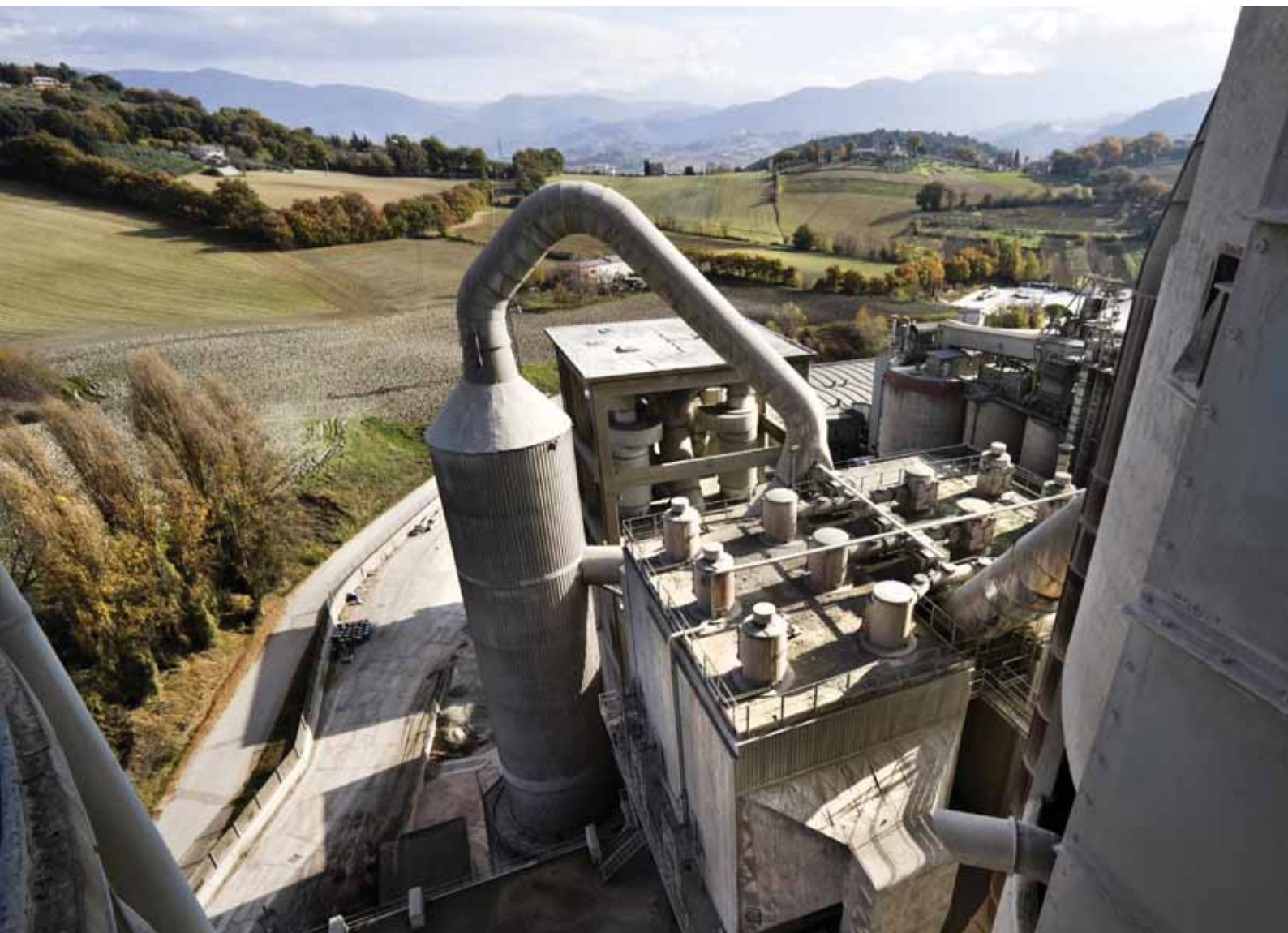
Stabilimento di Spoleto ITALIA
