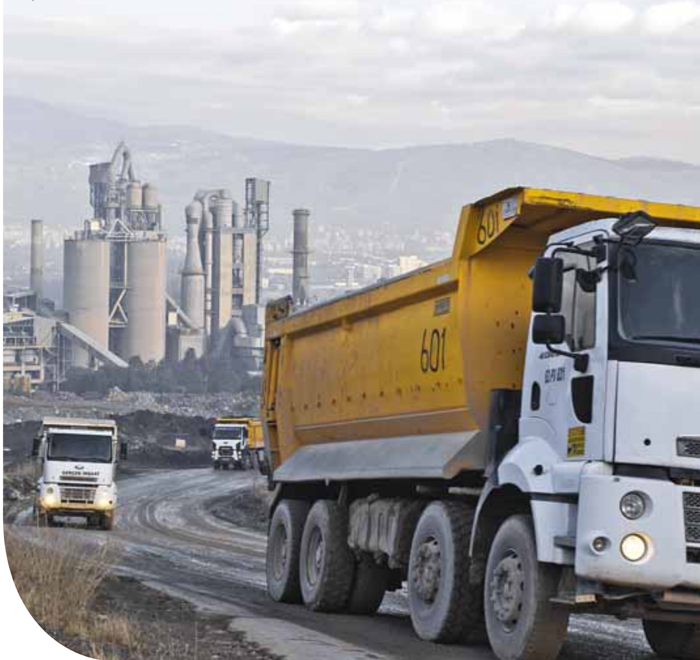
Impianto di Cimentas, Turchia
