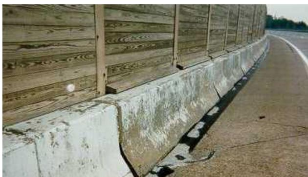
*Fig. 8: Barriere stradali in calcestruzzo grigio verniciate di bianco. Illustrano il pericolo per la sicurezza e dei costi aggiuntivi per la verniciatura.*
