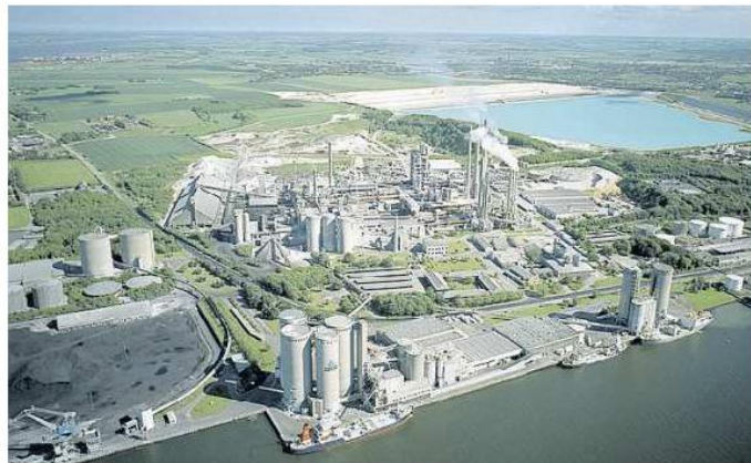
L'impianto di Aalborg di Cementir
